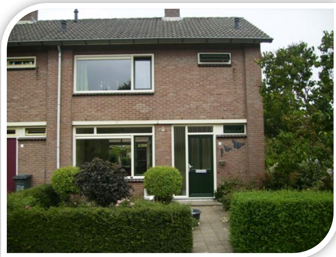
Renovatie Nieuwenhuisstraat Diepenveen
