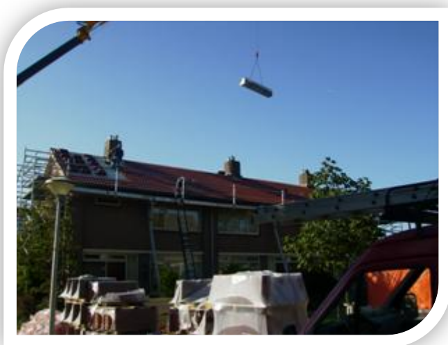
Renovatie Nieuwenhuisstraat Diepenveen
